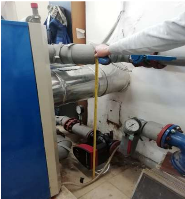
Zdjęcie nr 7- Pompa obiegowa i czopuch
