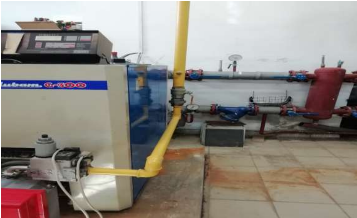
Zdjęcie nr 7- Pompa obiegowa i czopuch
